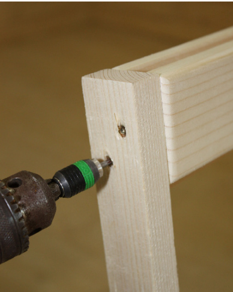
Transportleiste vom Türstock entfernen
