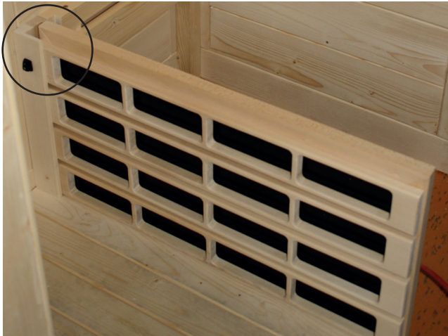
Abb. 33: Einsetzen der IR-Wärmeplatte VitaMy 164
