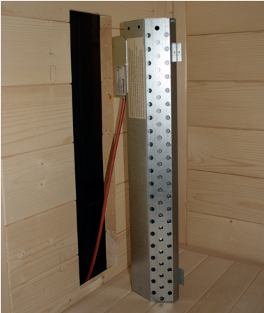
Abb. 37: Rückenstrahler (Infrarot-Strahler ECO 350) montieren
