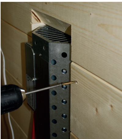
Abb. 38: Blende der Rückenstrahler montieren
