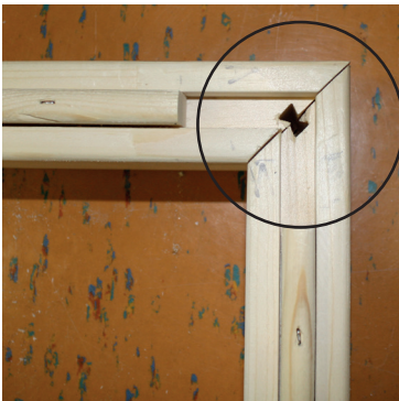
Abb. 2: Bodenelemente verbinden
