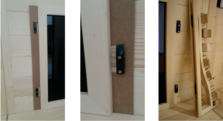
Abb. 49: Montage Rückenlehnen
