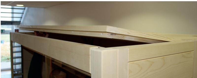
Abb. 18: Einlegen Dachelemente vorne
