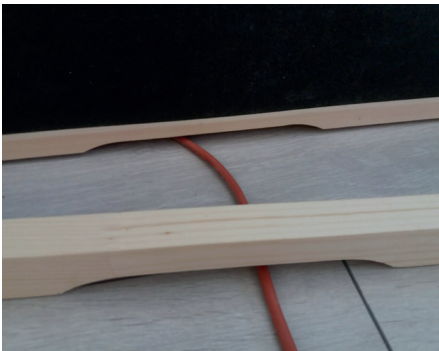
Abb. 34: Einsetzen der Aussteifungsleiste für IR-Wärmeplatten VitaMy
