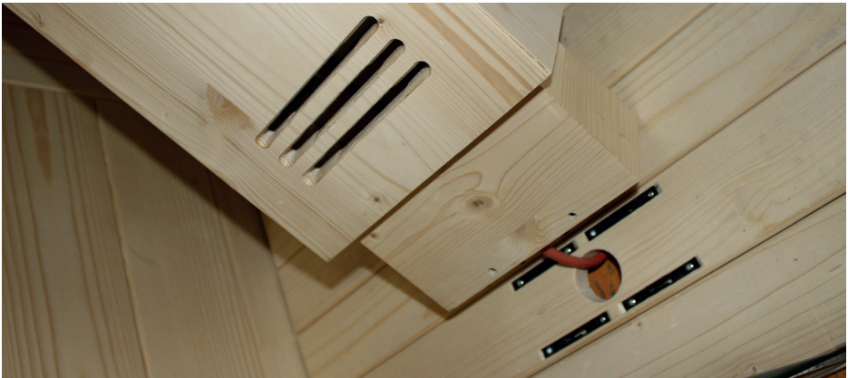
Abb. 28: Frontstrahler fixieren
