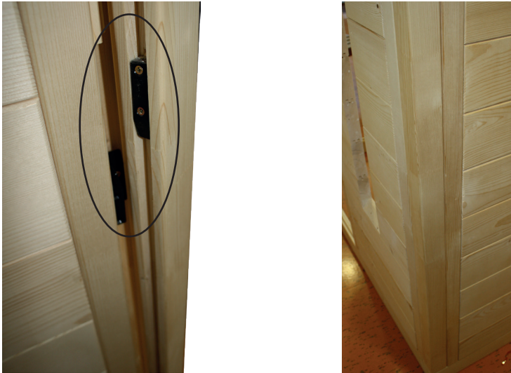
Abb. 4: Wandelemente mit Ecksteher verbinden
