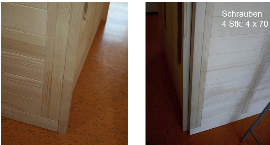
Abb. 47: Montage Abstandleisten Rückwand
