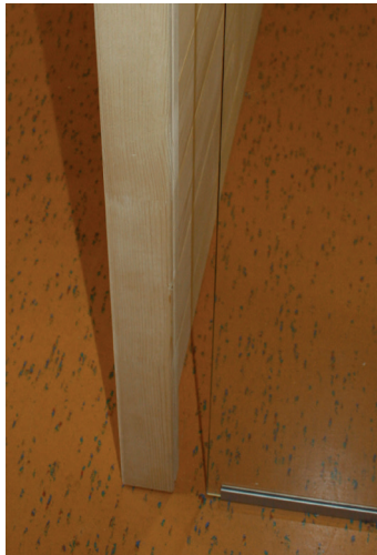
Abb. 12: Einsetzen der Glasscheibe in die Nut des Eckstehers
