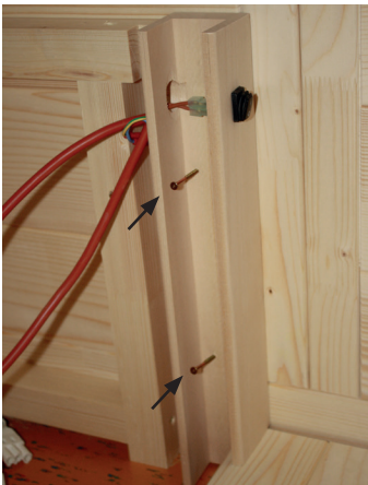
Abb. 32: Montage der U-Leisten für Wärmeplatten
