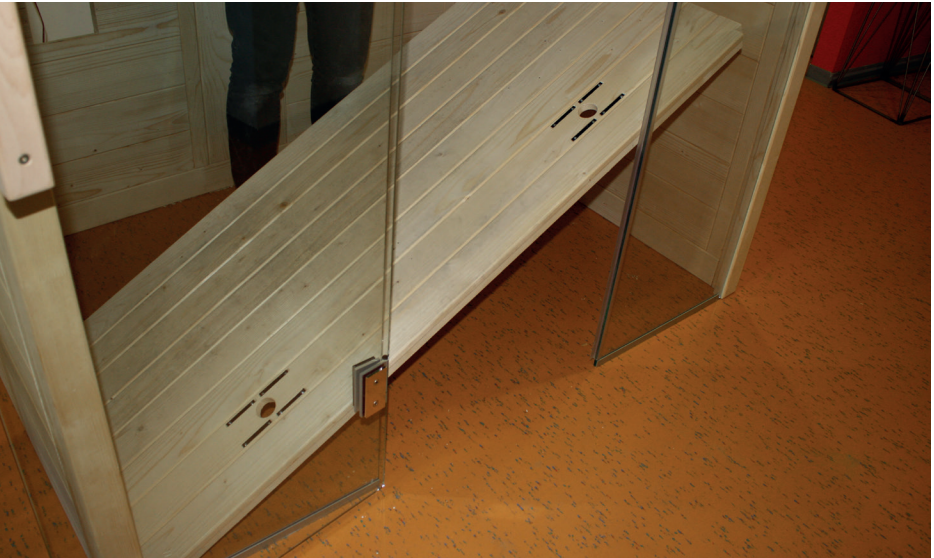
Abb. 27: Kabinenboden einlegen
