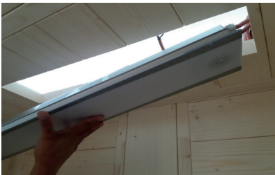
Abb. 45: Montage Farblampe
