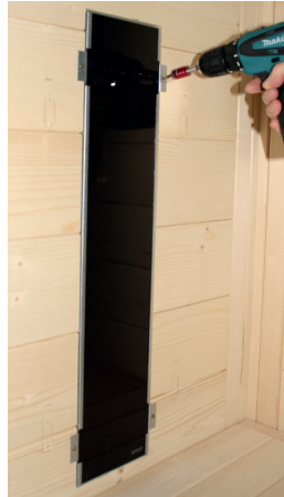
Abb. 37: Rückenstrahler (Infrarot-Strahler ECO 350) montieren
