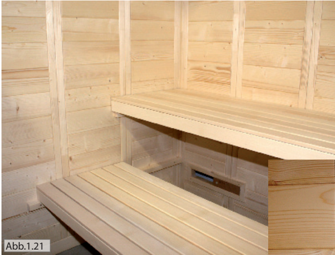
Montageleiste für Bankzwischenblende - Schrauben 4 x 60 mm
